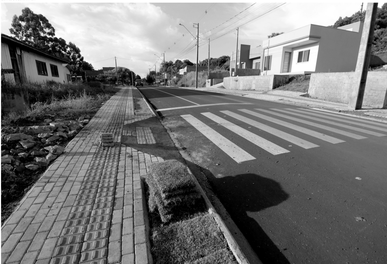
> A Secretaria de Estado das Cidades já recebeu projetos para a pavimentação de 251 municípios paranaenses de até 50 mil habitantes
