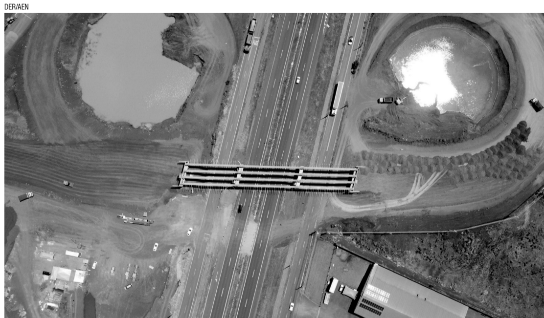
> O bloqueio total de tráfego na rua, que funciona como uma via marginal da rodovia federal, acontece até o dia 8 de fevereiro
