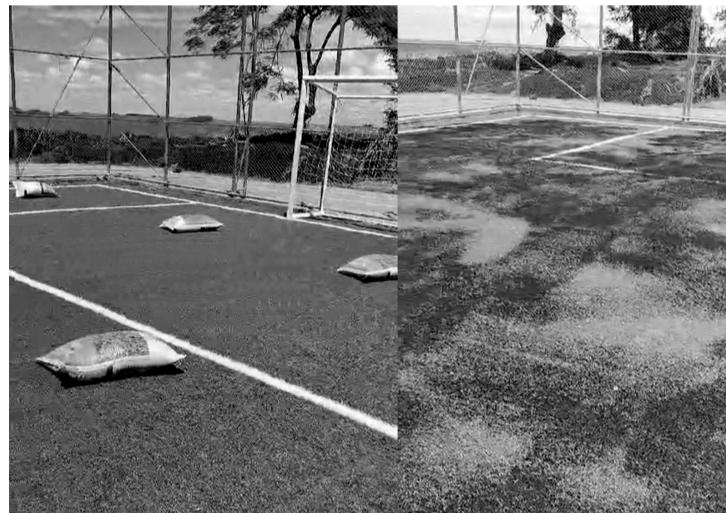
> A ação incluiu a reposição do granulado de borracha utilizado na composição da grama sintética
