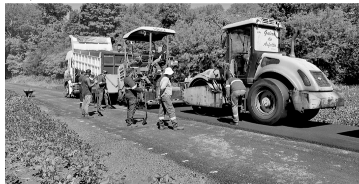
> O trecho atendido é na TM-36 com 1,9 km de extensão e 9.500 m2 de pavimentação asfáltica
