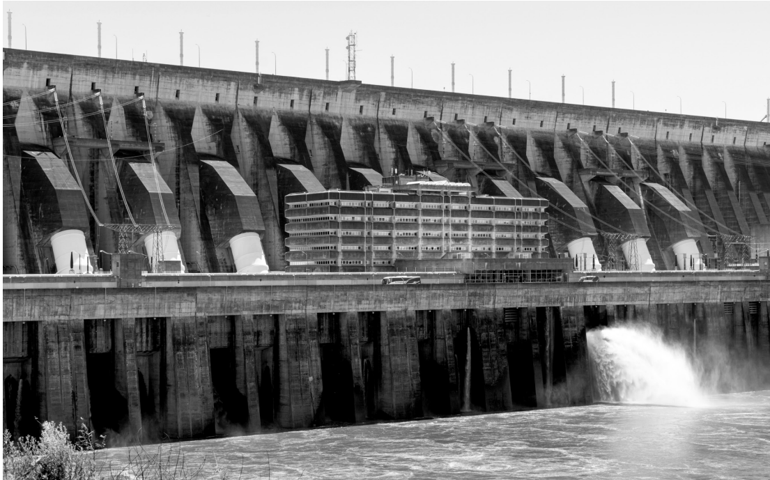
Usina gerou quase 84 milhões de MWh, 20% a mais que em 2022
